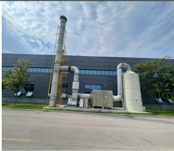
锅炉排气筒P8
